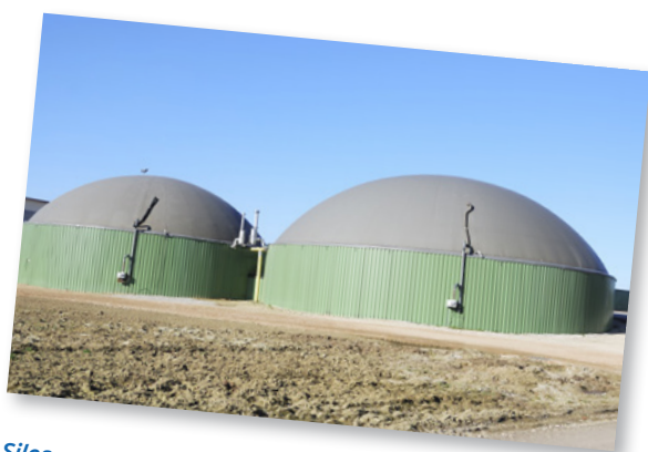
Silos permettant de produire du biogaz ou des biocarburants par fermentation de la biomasse. Photo: Production de biogaz – manfredxy, Shutterstock
