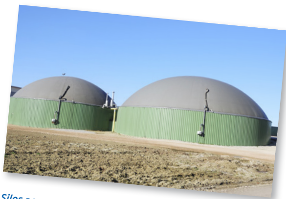
Silos permettant de produire du biogaz ou des biocarburants par fermentation de la biomasse. Photo: Production de biogaz – manfredxy, Shutterstock
