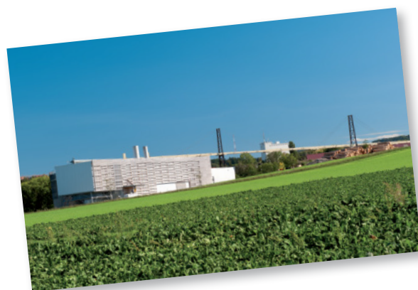
Grandes chaudières utilisées pour produire de l'électricité à partir de biomasse sèche. Photo: Centrale d'Enerbois, Rueyres – Romande Energie
